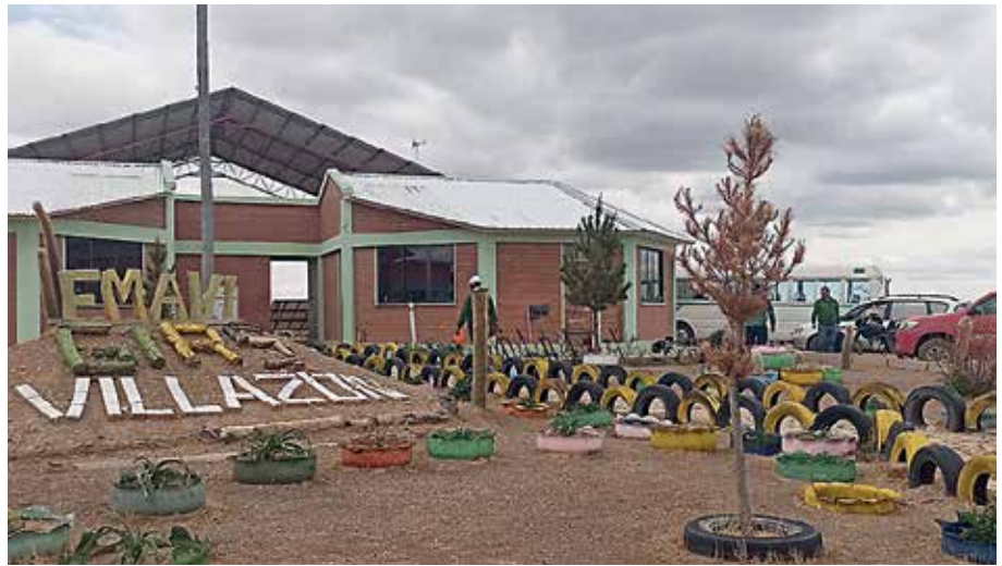
Obras complementarias del relleno sanitario de Villazón (Potosí) EMAVI.
